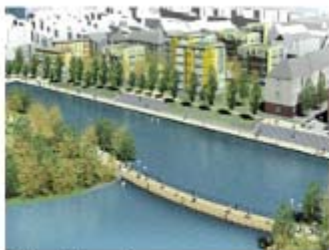
Stadtumbau (Abriss/Neubau) neuer Niederfeldsee
